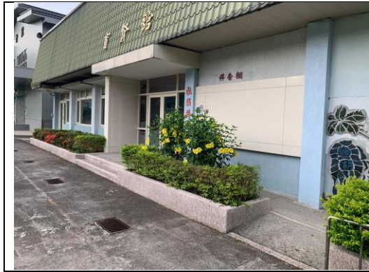
無障礙坡道：育賢館前
