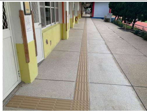
導盲磚：教學大樓 1F 走廊
